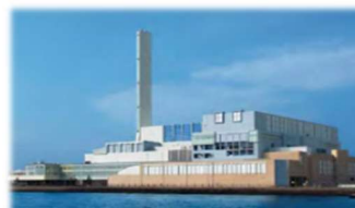
工場の新設・長寿命化工事
