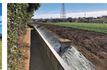
土砂流出防止対策／都筑区
