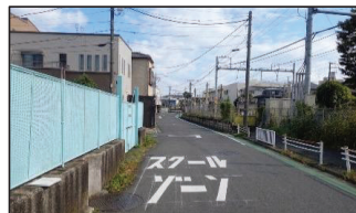
通学路 路面標示の補修
